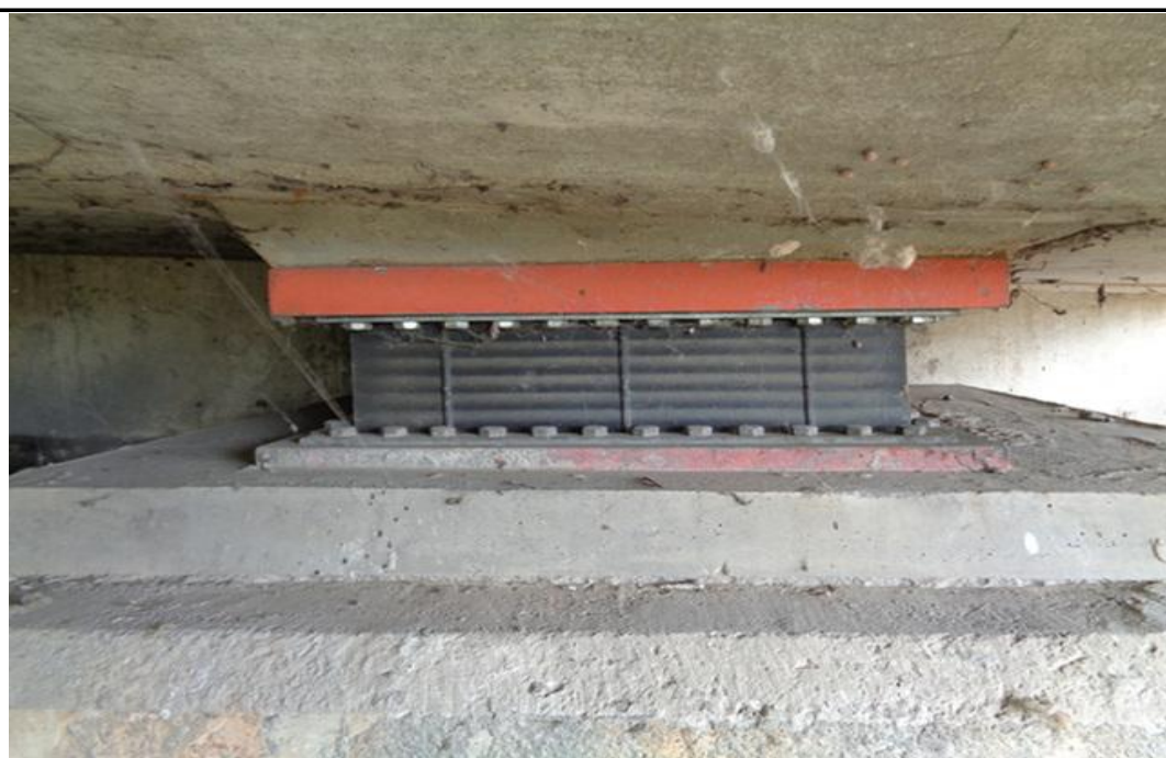
교량받침 전경 (탄성받침)
