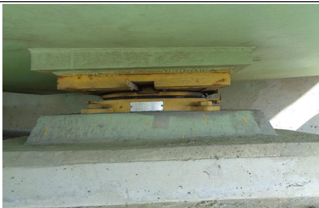
교량받침 전경 (포트받침)
