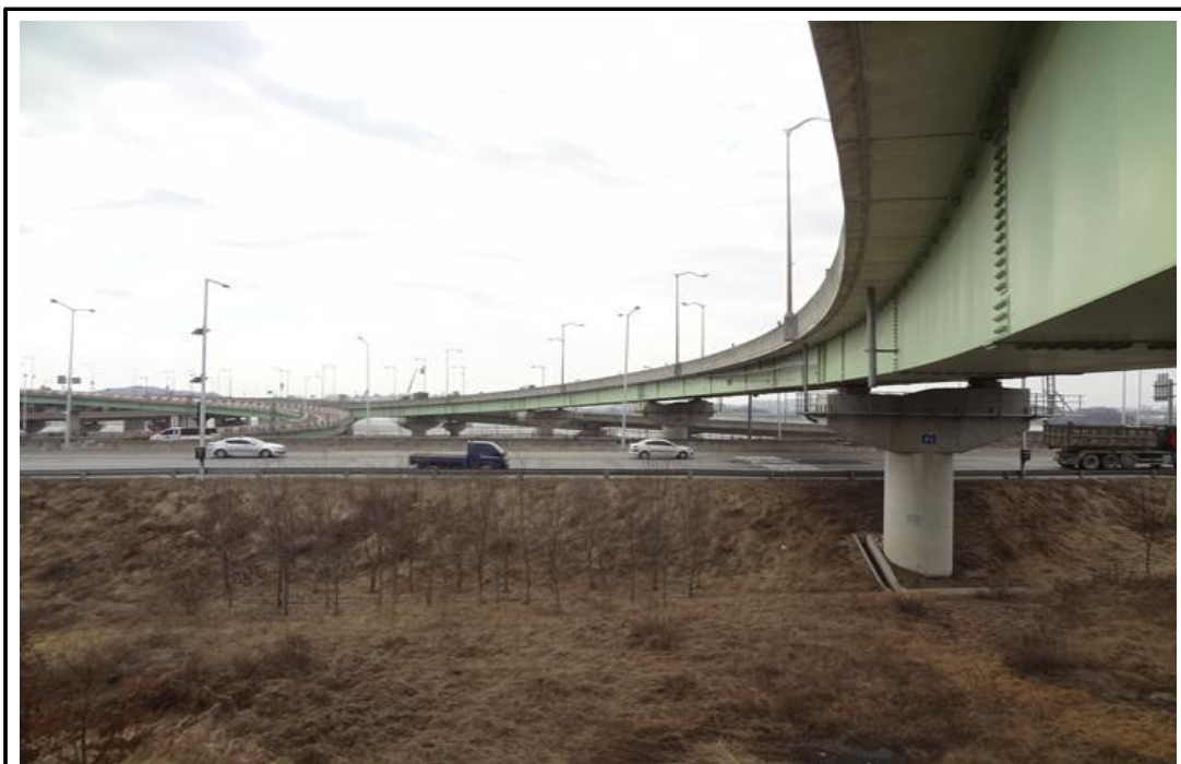
바닥판하면 및 거더 외부 전경(S1~5)
