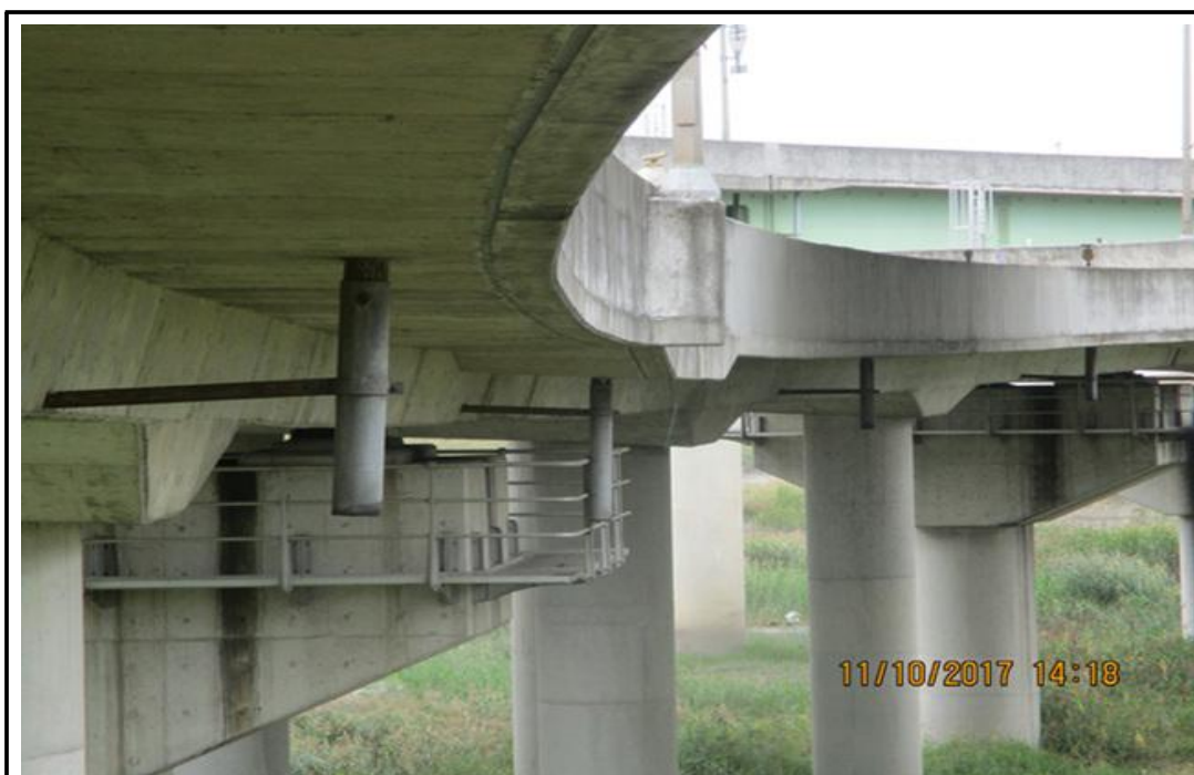
배수시설 전경 (산악형)
