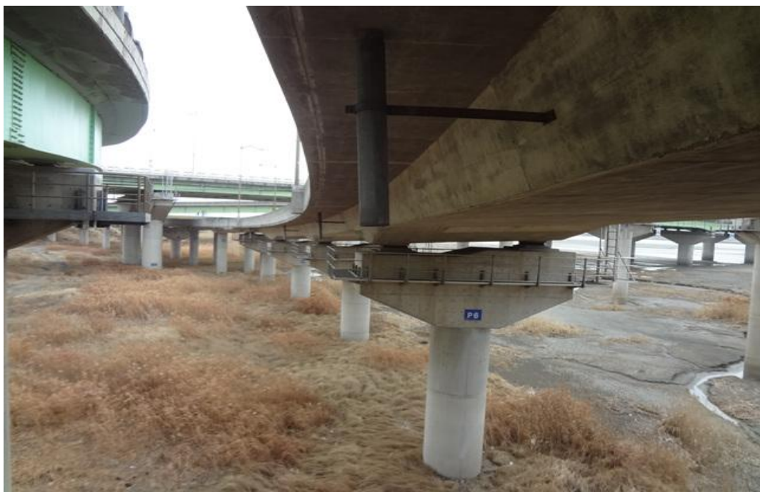
바닥판하면 전경(S6~9, S16~26)
