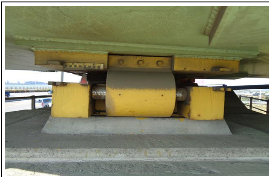
교량받침 전경 (내진받침)
